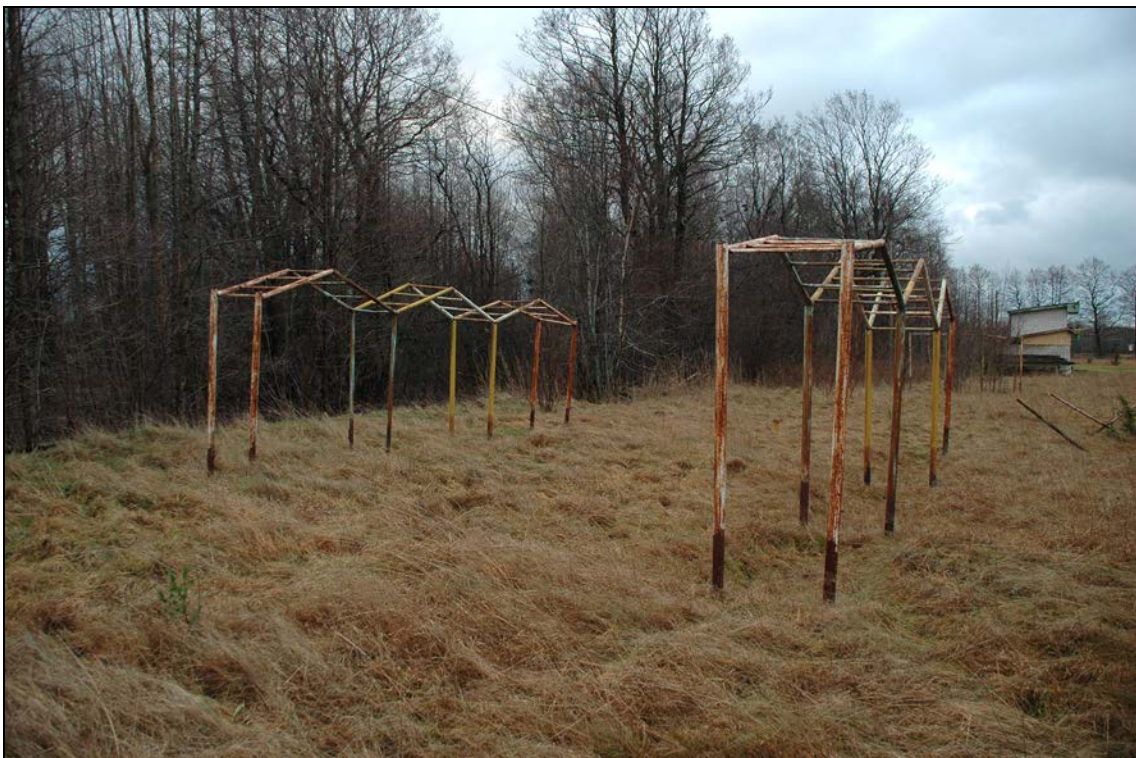
Foto 18 (30). Paope väliõppekeskus. Õppeväljak [6]. Need konstruktsioonid lammutati 2014. aastal. Foto Mart Mõniste 18.01.2007.
