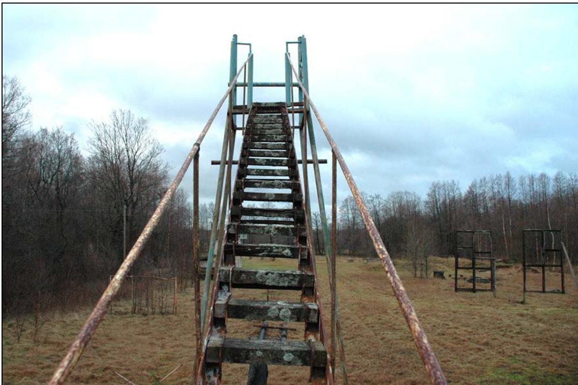
Foto 20 (34). Paope väliõppekeskus. Õppeväljak [6]. Need konstruktsioonid lammutati 2014. aastal. Foto Mart Mõniste 18.01.2007.
