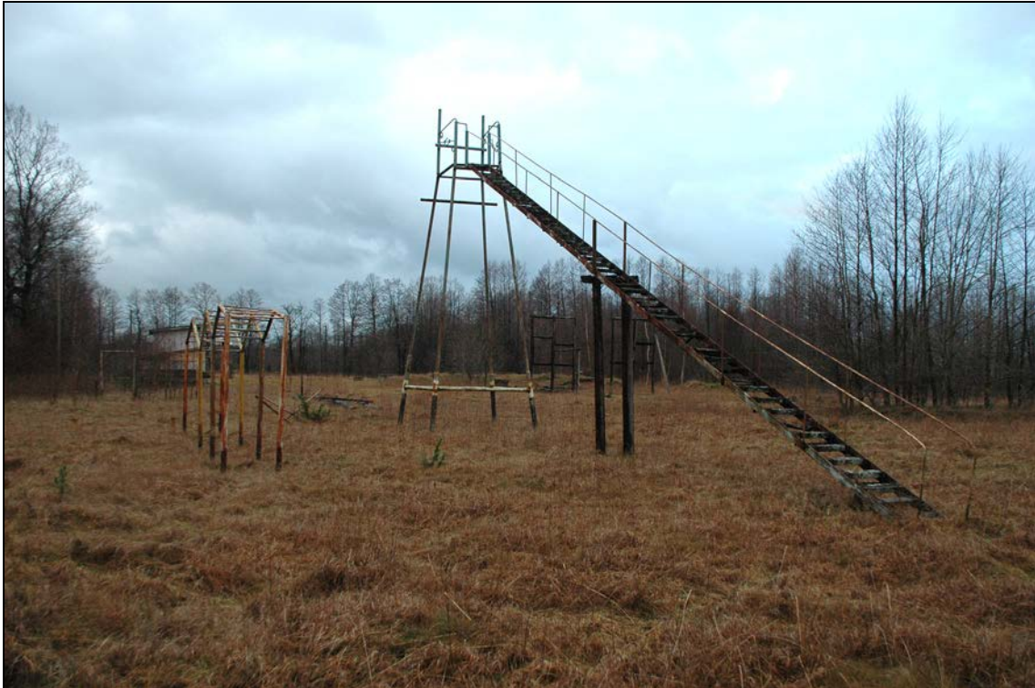
Foto 17 (29). Paope väliõppekeskus. Õppeväljak [6]. Need konstruktsioonid lammutati 2014. aastal. Foto Mart Mõniste 18.01.2007.
